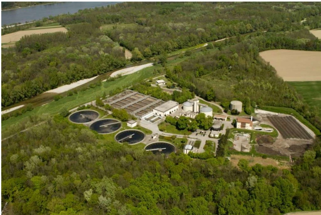
Abbildung 1: Abwasserverband an der Traisen, Betriebsgelände Traismauer
